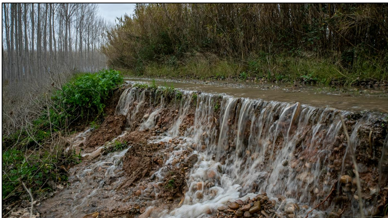
Figura 2. Inicio del desbordamiento de un dique y comienzo de la erosión en su trasdós (CHE).
