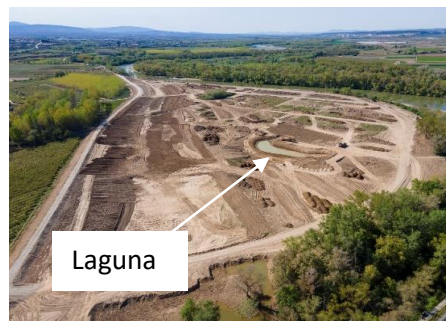
Figura 3. Vista aérea de las obras del meandro de La Roza (mayo 2023).
