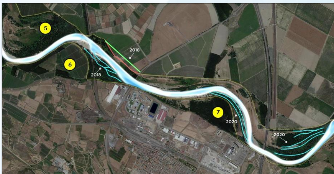
Figura 5. Intervenciones tipo curage realizadas en años anteriores.
