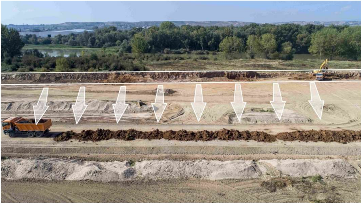
FORM B2B - FIGURA 4. RETRANQUEO DE LA DEFENSA DE LA MARGEN IZQUIERDA DEL RÍO EBRO ENTRE LOS MEANDROS DE LA ROZA Y EL SEÑORÍO (2018).
