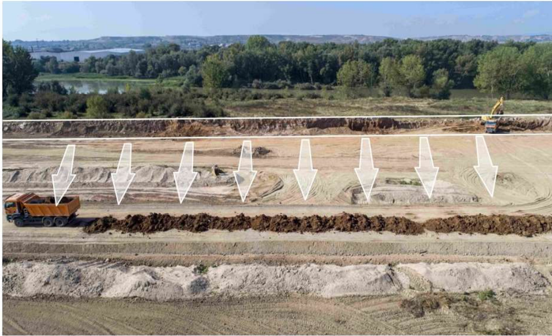
ACCIÓN B1 – FIGURA 6. RETRANQUEO DE LA DEFENSA IZQUIERDA ENTRE LOS MEANDROS DE LA ROZA Y EL SEÑORÍO (2018).
