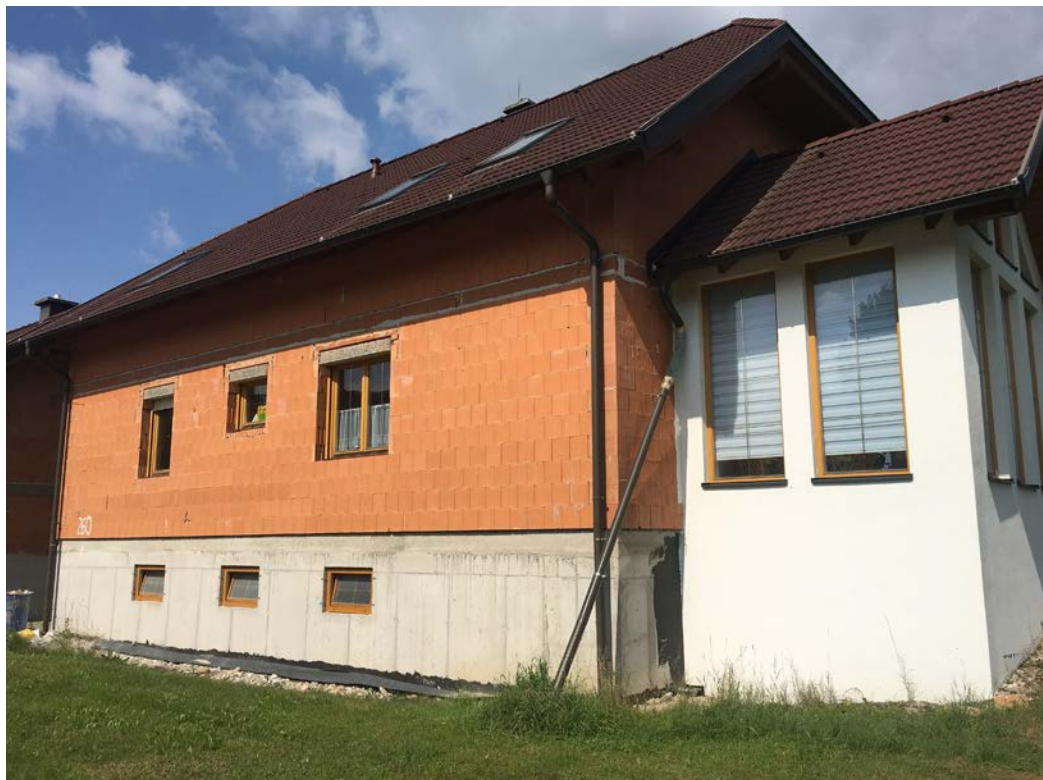
Figura 19. Materiales y aberturas resistentes en cota inundable.
