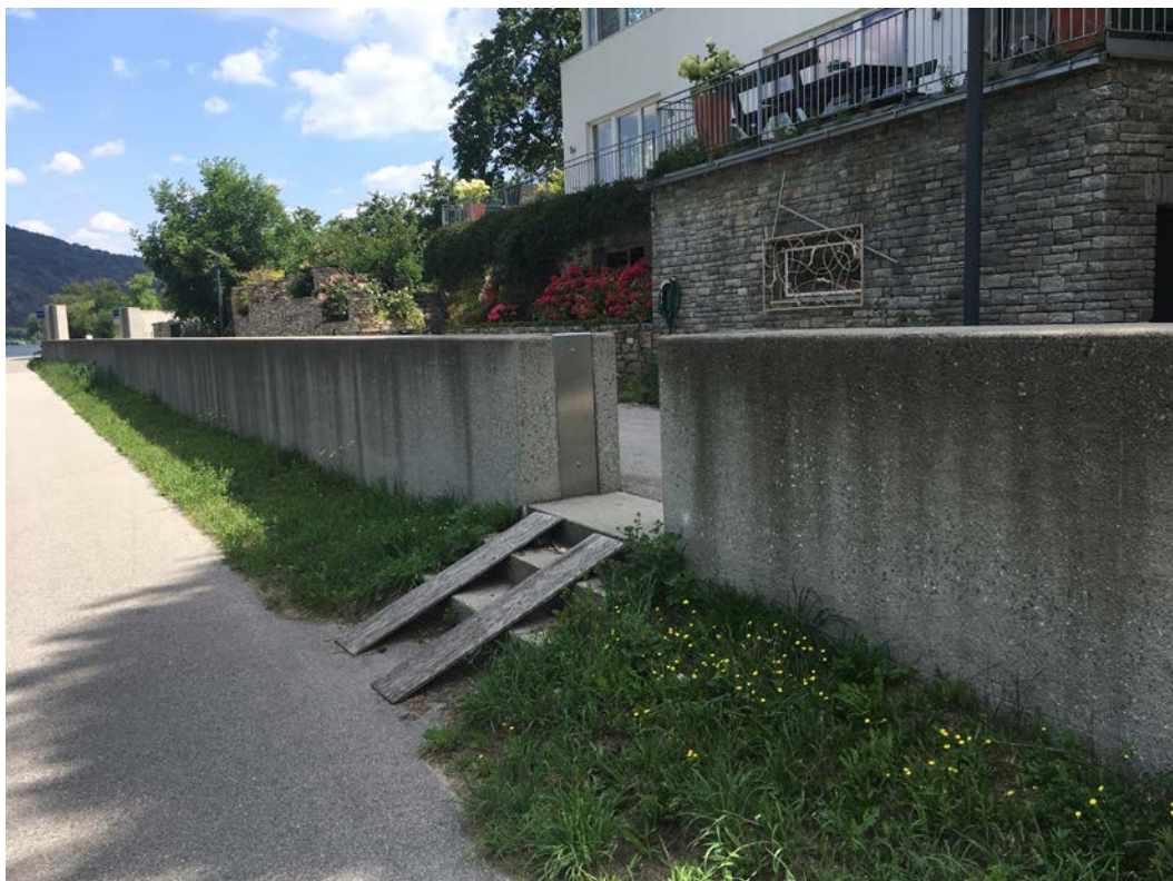
Figura 35. Muro estanco de protección.
