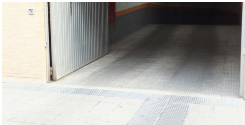
Figura 31. Acceso a garaje con tramo inicial ascendente.
