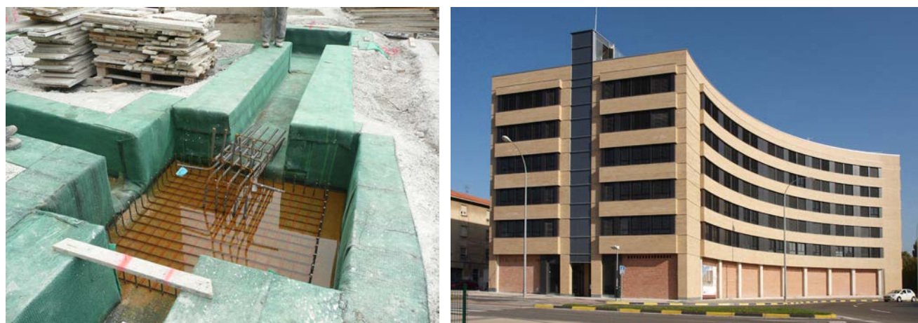
Figura 30. Protección cimentaciones con bentonita.
