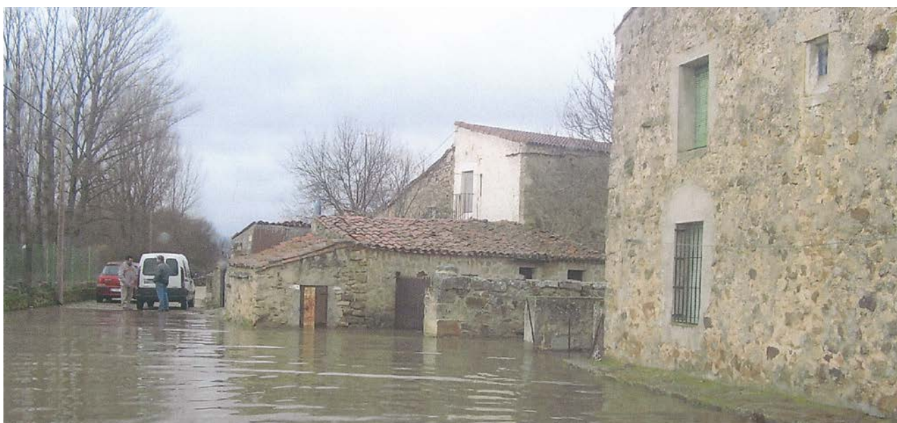
Figura 5. Afección inundación fluvial a edificio.
